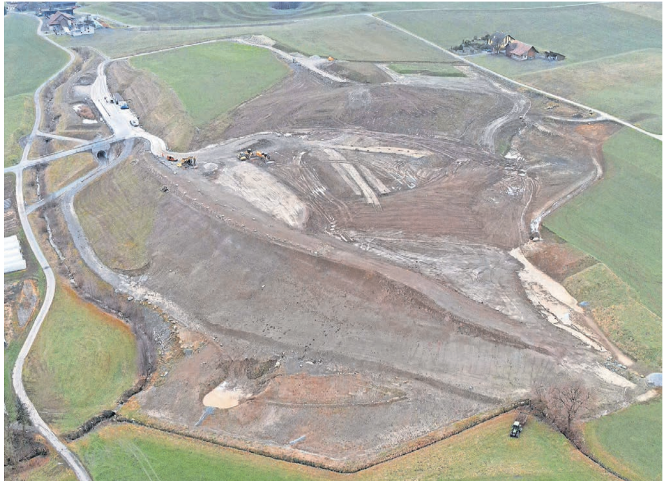
Eine Luftaufnahme vom Januar zeigt, wie gross die Deponie ist.
