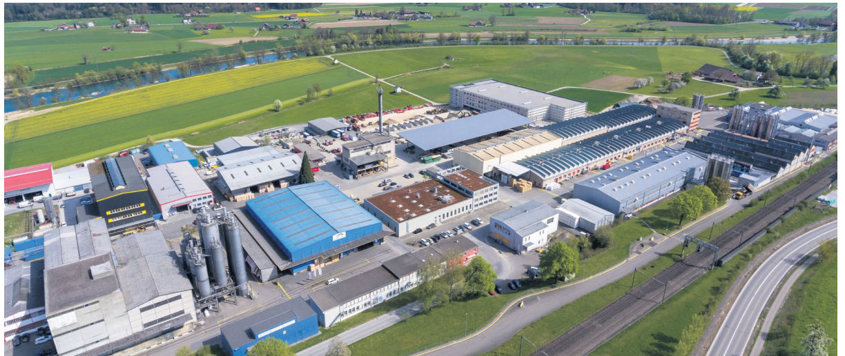
Durch das Standortförderungsprogramm FREIAMT.MITTENDRIN. erhält die Region mit den 19 Vertragsgemeinden der Repla Oberes Freiamt mehr Strahlkraft als attraktive Wirtschaftsregion. Bild: Industrie Nord, Sins.
